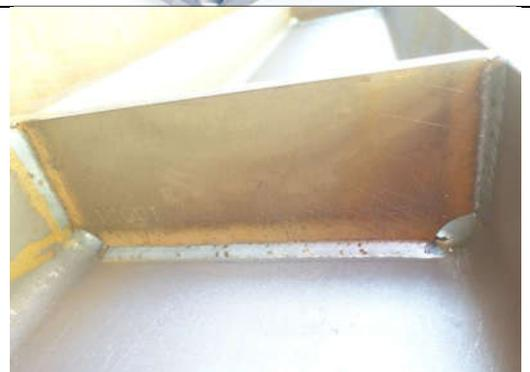
**Renfort avec trous de circulation, poutres en caissons avec évidements**
