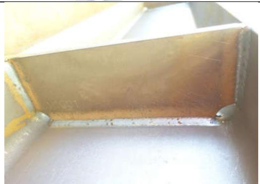
**Versteifung mit Zirkulationslöchern, Kastenträger mit Aussparungen**
